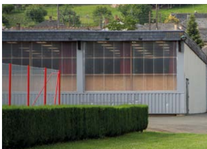
Rénovation du complexe sportif de Montsûrs : 550 000 €
