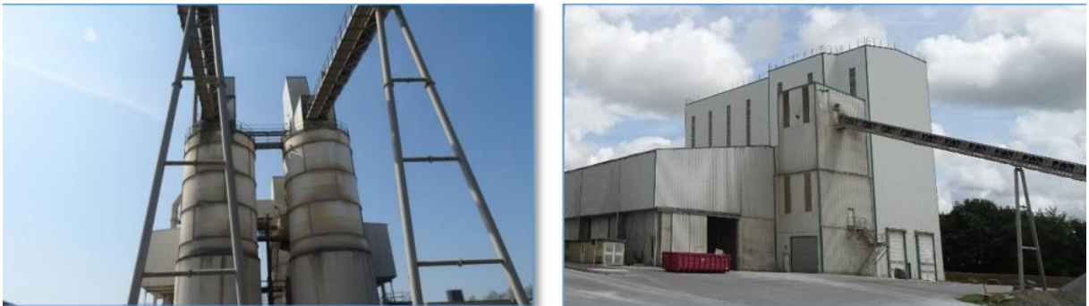
Figure 5 Vue sur le four à chaux et broyage et installation stockage chaux
